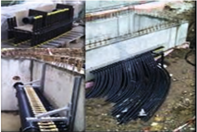
Baustellenbild: vor Ort erstellter Betonschacht
