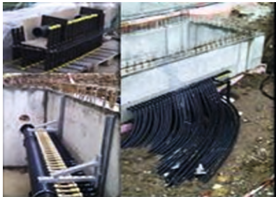
Baustellenbild: vor Ort erstellter Betonschacht
