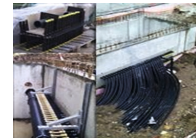
Baustellenbild: vor Ort erstellter Betonschacht
