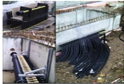
Baustellenbild: vor Ort erstellter Betonschacht
