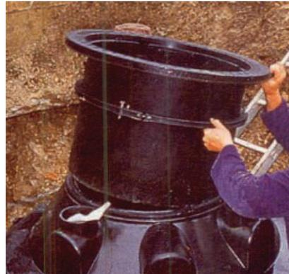
Einsetzen des höhenverstellbaren Aufsatzstückes. Den Klemmring vorher grob auf der gewünschten Einbauhöhe fixieren. Sollte es erforderlich sein, den Schaft zu kürzen, dann ist darauf zu achten, dass die Eintauchtiefe nicht zu gering wird. Die Abdeckplatte wird eingelegt, nachdem das Aufsatzstück in die Waagerechte gebracht wurde.
