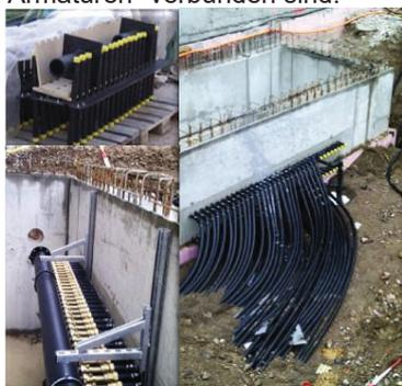
Wir empfehlen eine verlorene Schalung aus PE welche mit den Durchgangsrohren verschweißt ist und auf Höhe der Wandinnenseite positioniert wird. Es ist empfehlenswert mit einem Schalungsfenster in Größe der Systemplatte zu arbeiten und den Durchführungsbereich als Schalung „aufzusetzen“. (Details sind generell im Vorfeld mit NRTEC als Hersteller abzuklären.)
