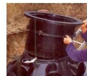
Einsetzen des höhenverstellbaren Aufsatzstückes. Den Klemmring vorher grob auf der gewünschten Einbauhöhe fixieren. Sollte es erforderlich sein, den Schaft zu kürzen, dann ist darauf zu achten, dass die Eintauchtiefe nicht zu gering wird, jedoch darf der Dom nicht auf dem Verteilerstamm aufsitzen!
