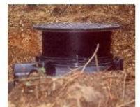
Einsetzen des höhenverstellbaren Aufsatzstückes. Den Klemmring vorher grob auf der gewünschten Einbauhöhe fixieren. Sollte es erforderlich sein, den Schaft zu kürzen, dann ist darauf zu achten, dass die Eintauchtiefe nicht zu gering wird, jedoch darf der Dom nicht auf dem Verteilerstamm aufsitzen!
