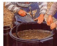
Montage der Dichtung zum Teleskop. Vor Montage unbedingt mit geeignetem Montagefett einfetten!
