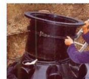
Einsetzen des höhenverstellbaren Aufsatzstückes. Den Klemmring vorher grob auf der gewünschten Einbauhöhe fixieren. Sollte es erforderlich sein, den Schaft zu kürzen, dann ist darauf zu achten, dass die Eintauchtiefe nicht zu gering wird, jedoch darf der Dom nicht auf dem Verteilerstamm aufsitzen!
