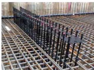
Systemaufbau in der Bewehrung mit zus. Führungsplatte für die Abstandsfixierung der Durchgangsrohre
