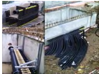
Baustellenbild: vor Ort erstellter Betonschacht
