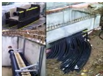
Baustellenbild: vor Ort erstellter Betonschacht
