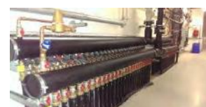
GT-System nach der Fertigstellung des
