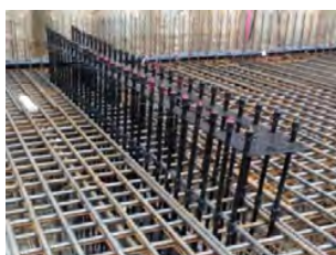
Systemaufbau in der Bewehrung mit zus. Führungsplatte für die Abstandsfixierung der Durchgangsrohre
