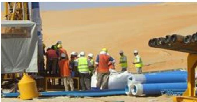
Die für den Einbau relevanten Werte sind neben der Rohrdimension insbesondere die Tragfähigkeit der gewählten Gewindeverbindung und die Aussendruckfestigkeit.
